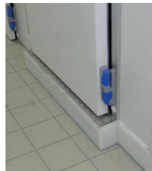
Seuil de chambre froide
