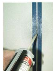
Joint bi-composant d'étanchéite entre plaques
