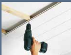
Pose sur ossature bois
